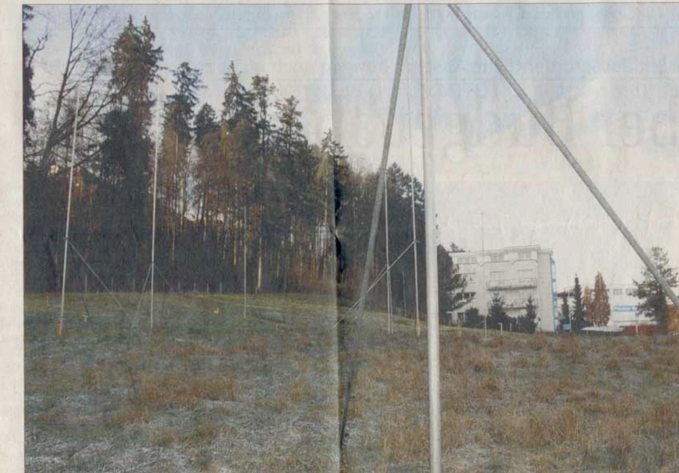
Die Baugestänge zeigen es an: An der Moosacherstrasse sind Neubauten geplant. (Oliver Lutz)
